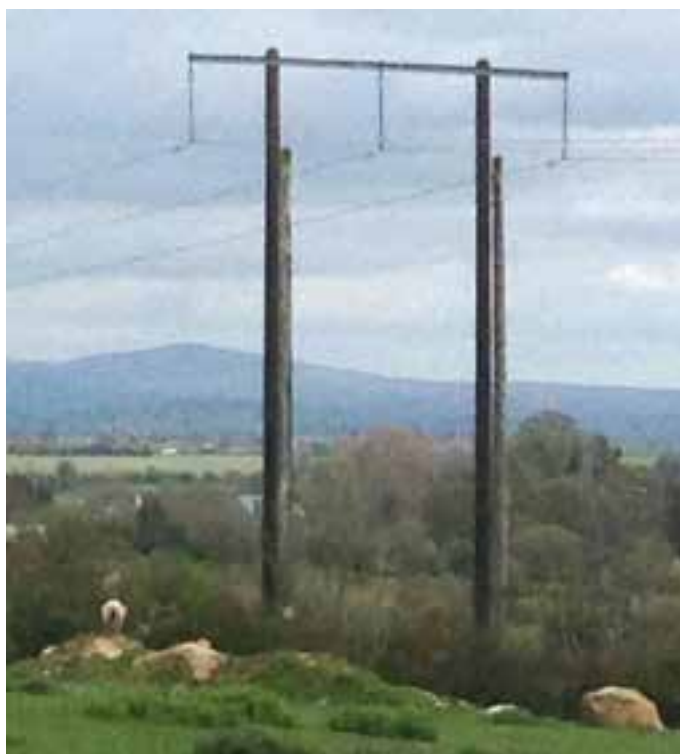
Fíor 4.5: Sampla de chuaille adhmaid 110 kV reatha á athsholáthar le cuaille adhmaid nua agus níos airde (sean-chuailí fós le baint)
